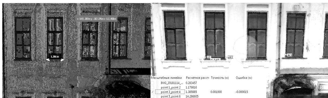
Рис. 1. Сравнение методов фотограмметрии с лазерным сканированием фасада здания
